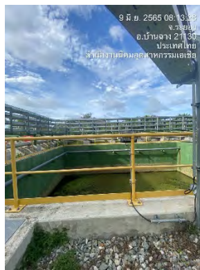
ภาพที่ 2.2-11 บ่อพักน้ำลูกเหินขนาด 320 ลูกบาศก์เมตร
