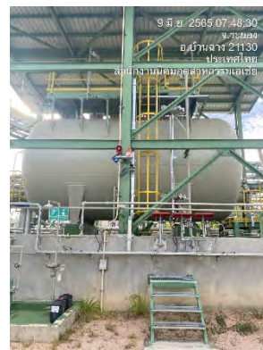
ภาพที่ 2.2-32 ถังกักเก็บแอมโมเนียมไฮดรอกไซด์เหลว
