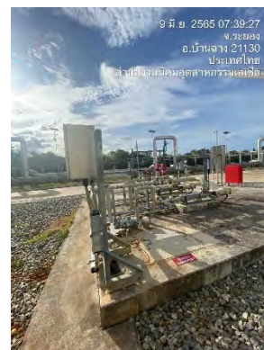
ภาพที่ 2.2-6 ระบบรวบรวมน้ำที่อาจปนเปื้อนน้ำมัน
