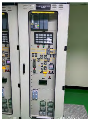
ภาพที่ 2.2-46 ระบบป้องกันทางไฟฟ้า (Relay) ที่เครื่องกำเนิดไฟฟ้า และหม้อแปลงไฟฟ้า
