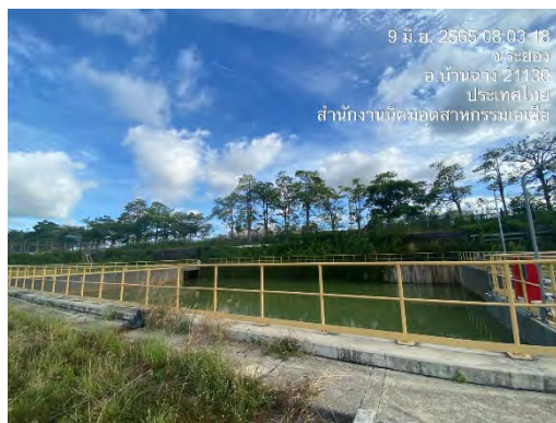
ภาพที่ 2.2-22 บ่อหน่วงน้ำ ขนาด 2,880 ลูกบาศก์เมตร
