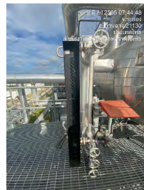
ภาพที่ 2.2-43 มาตรการระดับน้ำที่หม้อน้ำ
