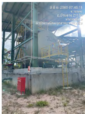
ภาพที่ 2.2-32 ถังกักเก็บแอมโมเนียมไฮดรอกไซด์เหลว
