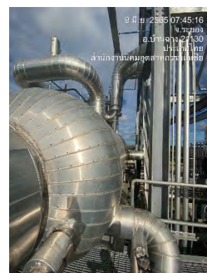
ภาพที่ 2.2-45 ฉนวนหุ้มเปลือกหม้อน้ำ
