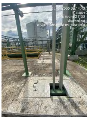
ภาพที่ 2.2-7 ถังแยกน้ำมัน (Oil-Water Separator)
