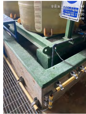
ภาพที่ 2.2-31 Dike ล้อมรอบถังเก็บสารเคมี
