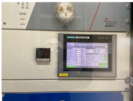
ภาพที่ 2.2-3 หน้าจอระบบการเตือน (Alarm) เพื่อควบคุมการระบายก๊าซออกไซด์ของไนโตรเจน ( \text{NO}_x )
