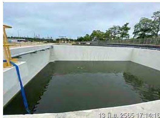
ภาพที่ 2.2-12 บ่อพักน้ำลูกเหินขนาด 1,800 ลูกบาศก์เมตร
