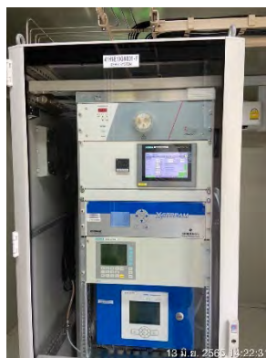
ภาพที่ 2.2-2 ระบบ CEMS จากปล่อง HRSGs 1
