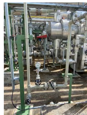
ภาพที่ 2.2-37 Shut-off Valve บริเวณ Connection
