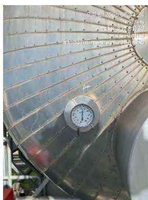
ภาพที่ 2.2-44 มาตรการวัดความดันไอน้ำที่หม้อน้ำ
